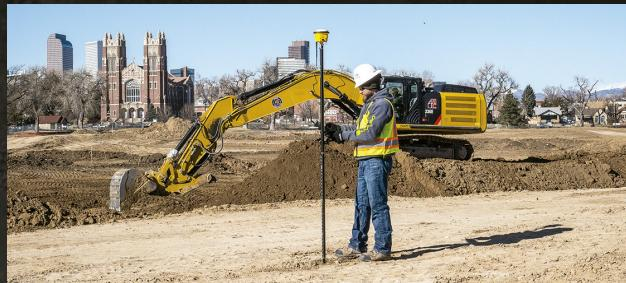
Trimble Siteworks Positioning System for Construction Surveyors は、SPS986 または SPS785 GNSS スマートアンテナ、TSC7 コントローラ及び Siteworks ソフトウェアで構成されます。測量技士が行う複雑で大量のな 3D データをより素早く収集し、詳細な 3D モデルをよりその場でビジュアル化、問わず効率よく作業を行うことができます。
